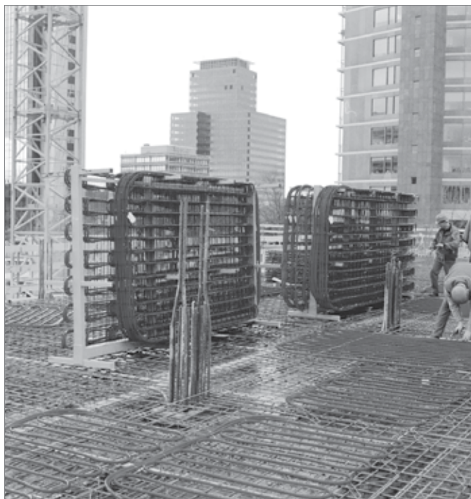
Подогрев и охлаждение ядра бетонных перекрытий
