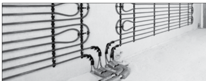
Система напольного отопления/охлаждения («мокрый» способ укладки труб)
